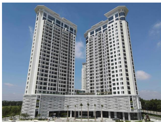
▲SORA gardens II 外観
